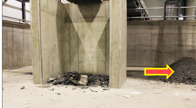
Kuva 2. Kuonabunkkeri, jossa magneettisten metallien erottelu
